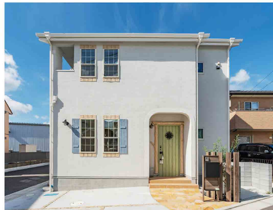
施工：株式会社Best Stage 外壁：ユニブラルSL #403 窓回り：ユニブラルSL #010 のこ肌石積み 鏡戸：ユニブラルSL 特注色 擬木
