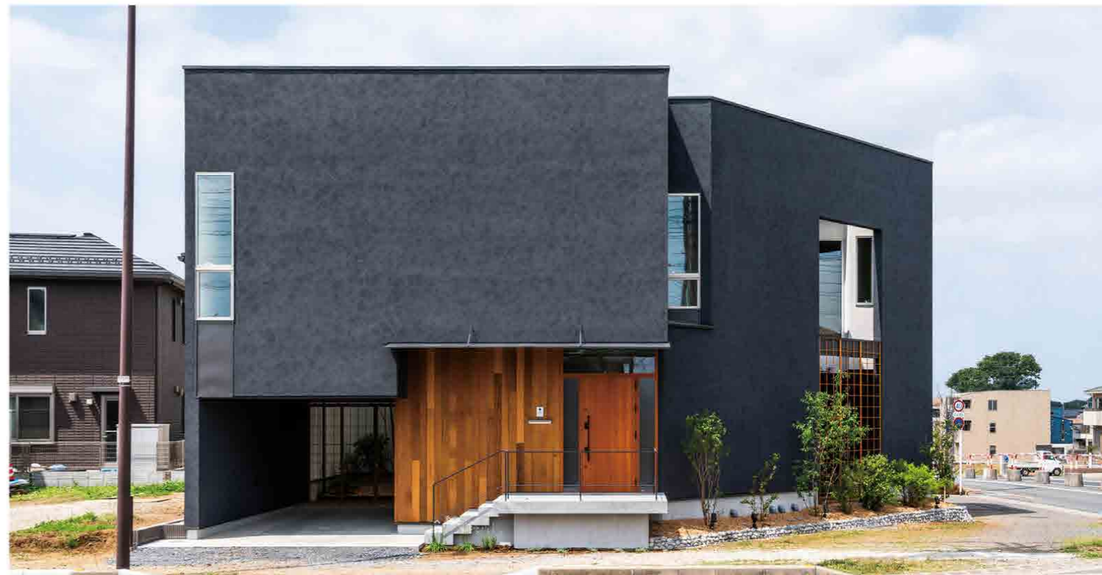
施工：共栄建築株式会社 外壁：ユニブラルHY+ #417 浮雲
