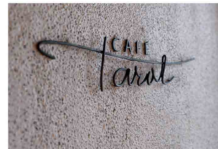
カフェタロー 設計：株式会社ルビオ岩崎デザイン事務所 壁：ユニプラルSL #276+ #400 洗い出し photo：馬場道浩
