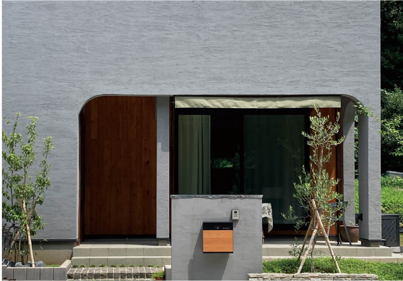
施工：古河林業株式会社 外壁：ユニプラルHY+ #400 フレスコ
