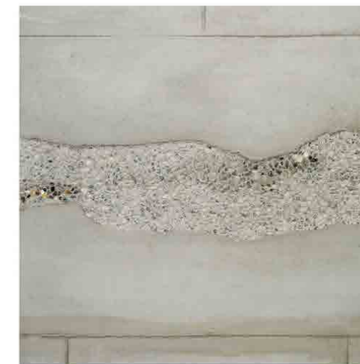
版築(はんちく) 版築をイメージした仕上げ。 ※部分的に大きめの骨材を混ぜ合わせて作ります。 仕上厚：12~15mm
