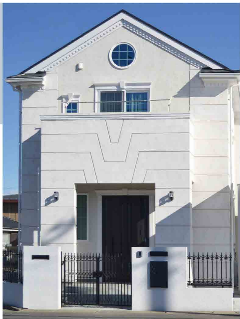
施工：ロビンスジャパン株式会社 外壁：ユニプラルHY+ #000 ノワ、ユニプラルSL #000 ライムストーン石積み
