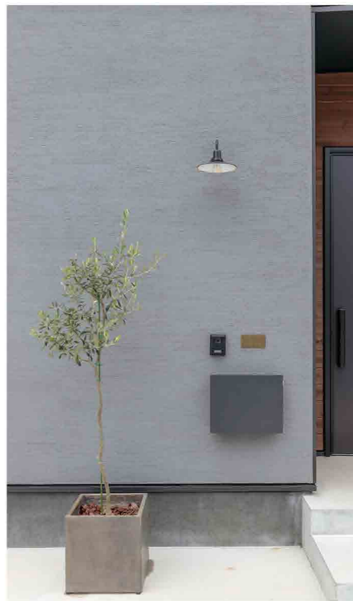
施工：株式会社Kibaco 外壁：ユニプラルHY+ #400 フレスコ
